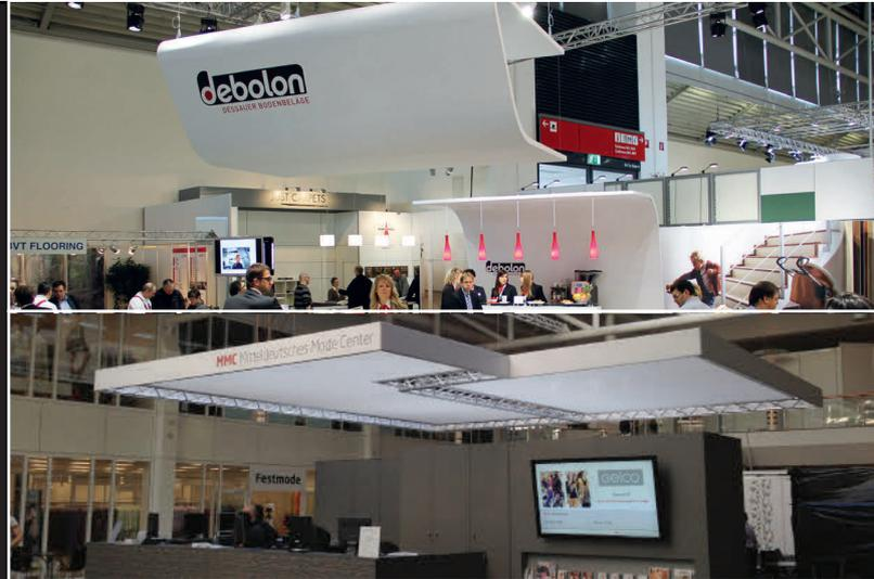
Aluminium-Unterkonstruktion, geschweißt, mit Textil bespannt
